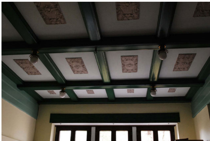
Abb.9 Holzkassettendecke im Erdgeschoss des Pfarrhauses
