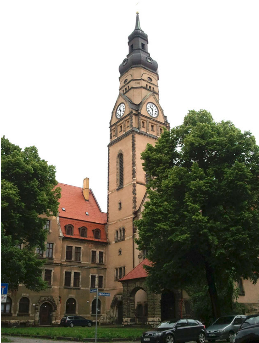
Abb.6 Blick vom Vorplatz auf die Eingangssituation
