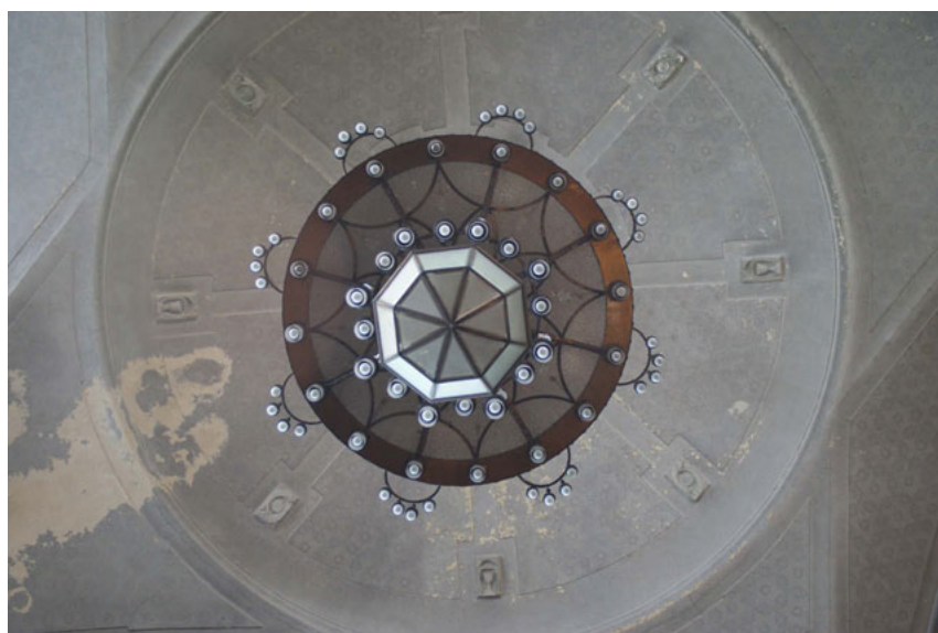
Abb.11 Blick auf Untersicht Kronleuchter
